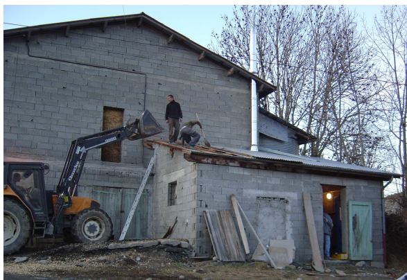
Photo 1 : Chantier de construction de la chaufferie et du silo
