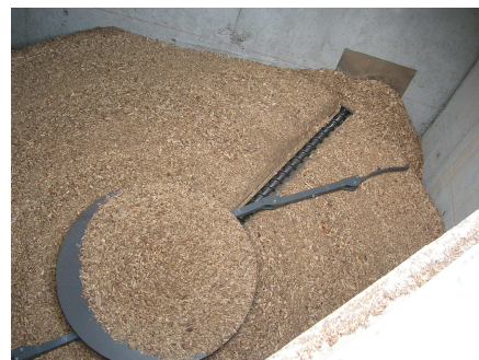
Photo 2 : Intérieur du silo de stockage
