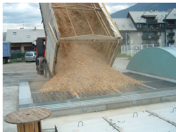
Photo 2 : Livraison par camion-benne du silo à trappe coulissante de la chaufferie Delaroché
