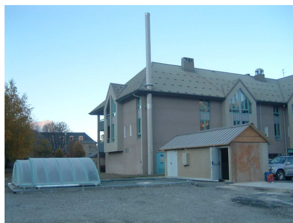
Photo 1 : Vue extérieure de la chaufferie et du silo du réseau de chaleur Delaroché
