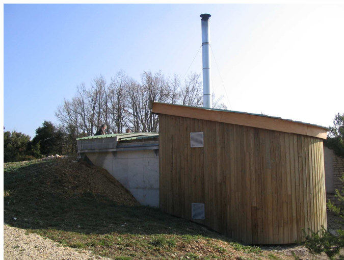
Photo 2 : Vue extérieure de la chaufferie et du silo
